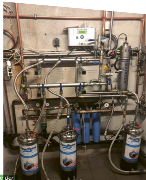
Drei neue Filter vor der bestehenden Trinkwasserreinigungsanlage
